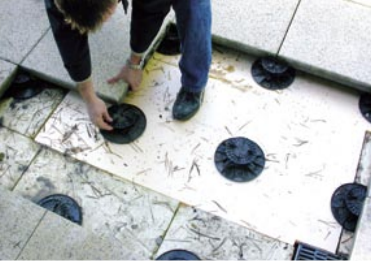
^ Le CSTB réalise des études sur le terrain pour évaluer les performances thermiques des procédés en œuvre : prélèvement sur une toiture à isolation inversée.
