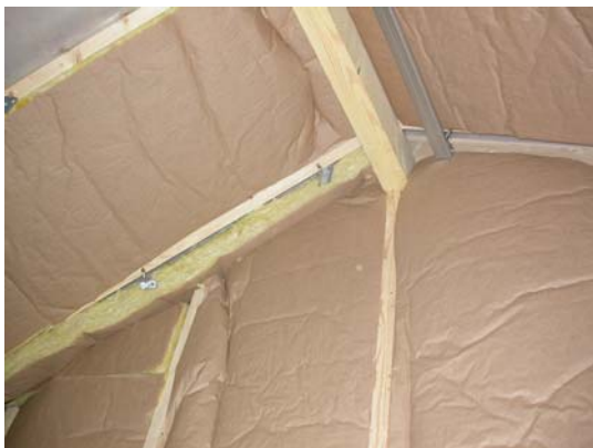
Photographie 3 : Vue de l'isolation de la panne faîtière
