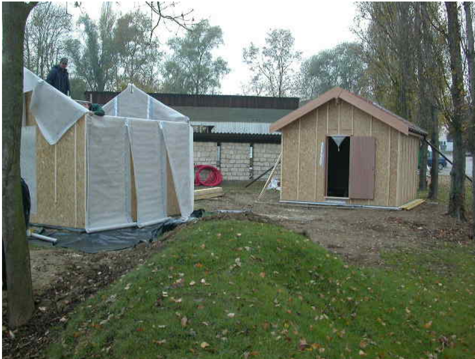
Photographie 2 : Mise en place de la membrane pare air
