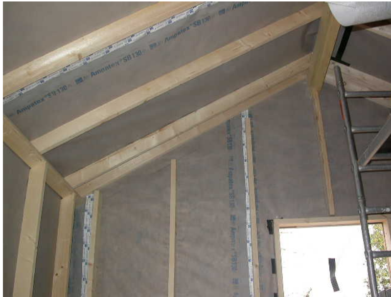
Photographie 1 : Vue de l'intérieur avant la pose de l'isolant et du parement : pose de la membrane d'étanchéité à l'air
