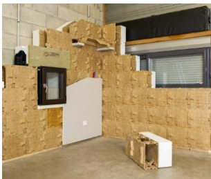
Mur complet réalisé avec des blocs Isostal
