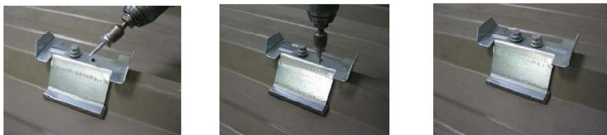
Figure 21 - Illustration de la fixation du perçage des panneaux sandwich et de la pose de l'entretoise
