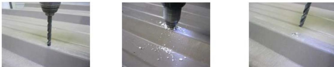
Eliminer l'isolant remonté à la surface et les copeaux de perçage pouvant se trouver sur la peau extérieure du panneau sandwich.
