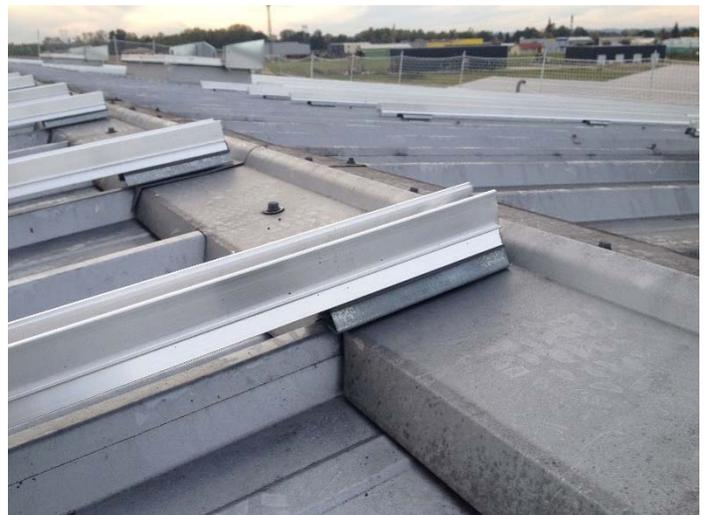
Figure 23 – Illustration de l'utilisation de la rehausse de faîtiage
