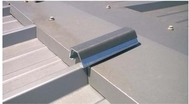
Positionnement des rehausse de faîtiage : une seule par colonne de rails
