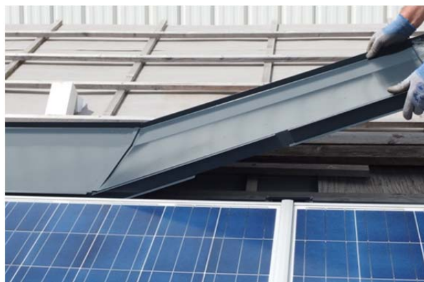
emboîtement du capot arrière au-dessus du module et du couloir latéral
