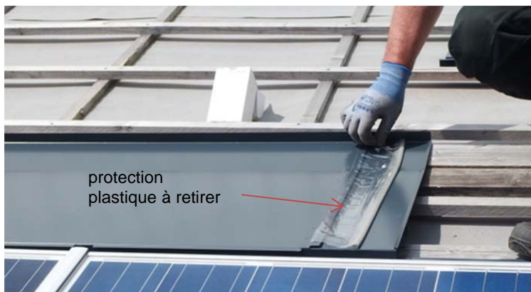
emboîtement du capot arrière au-dessus du module et du couloir latéral
