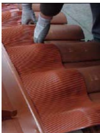
marouflage de la bande souple de la bavette avant
