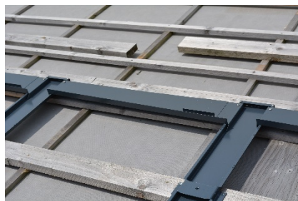
couloir transversal / écarteur / couloir intermédiaire
