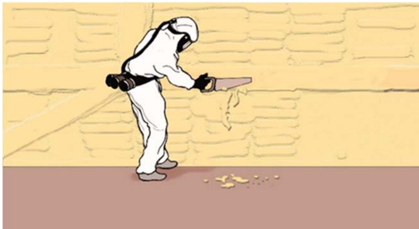
Figure 18 : Ecrêtage des surépaisseurs
