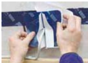
Figure 5 : Mise en œuvre de la manchette Kaflex Post
