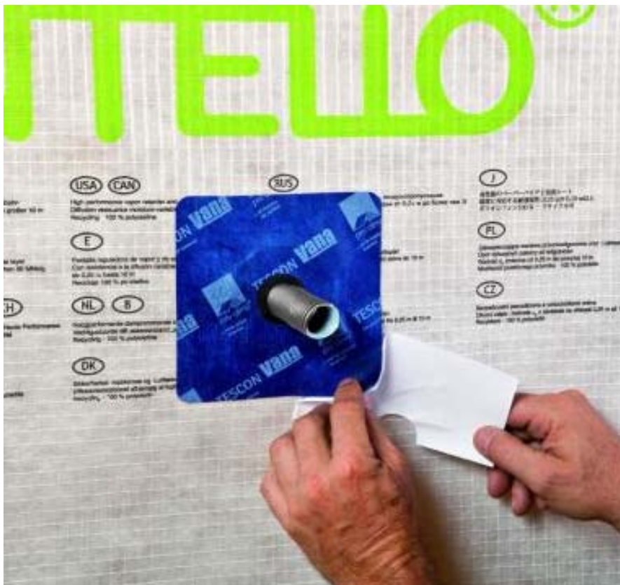
Figure 30 : Mise en place de la manchette ROFLEX 20
