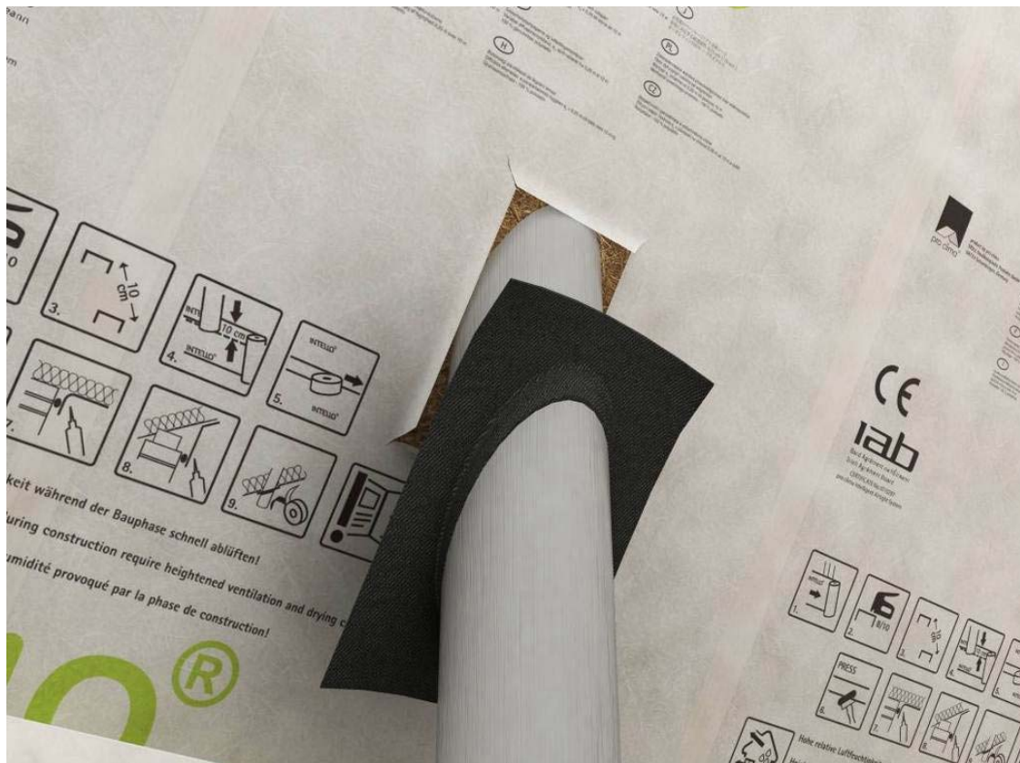
Figure 31 : Mise en œuvre de la manchette ROFLEX sur le conduit
