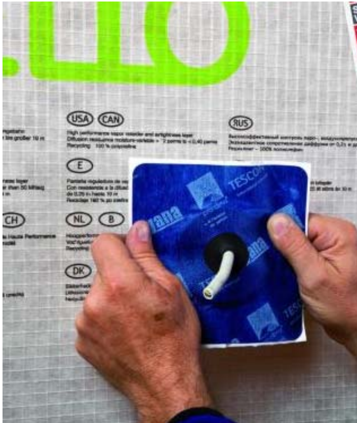
Figure 29 : Collage de la manchette KAFLEX sur la membrane INTELLO / INTELLO PLUS
