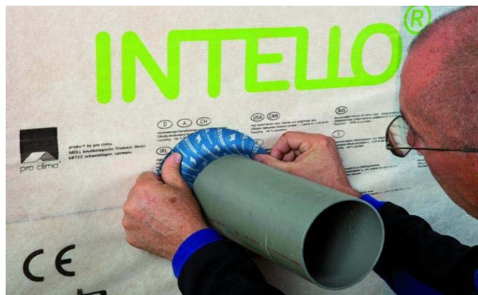
Figure 8 : Collage de la manchette EXTONSEAL Magov sur la membrane INTELLO / INTELLO PLUS
