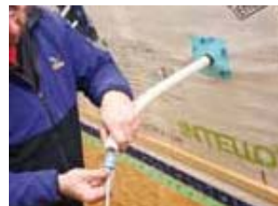
Figure 7 : Mise en place du bouchon STOPPA
