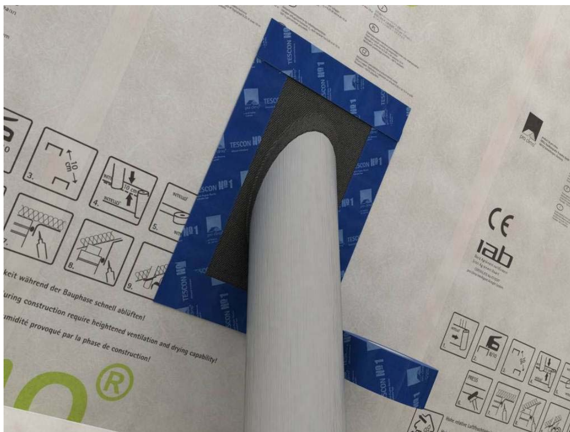
Figure 32 : Mise en œuvre de la manchette ROFLEX sur la membrane INTELLO / INTELLO PLUS
