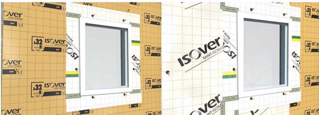
→2-Collage de la Vario® Xtra Band sur la membrane et pose de multitaape aux angles pour parfaire l'étanchéité à l'air
