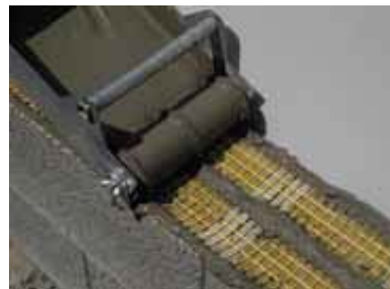
Application d'une 2 ème couche de colle au-dessus de l'armature
