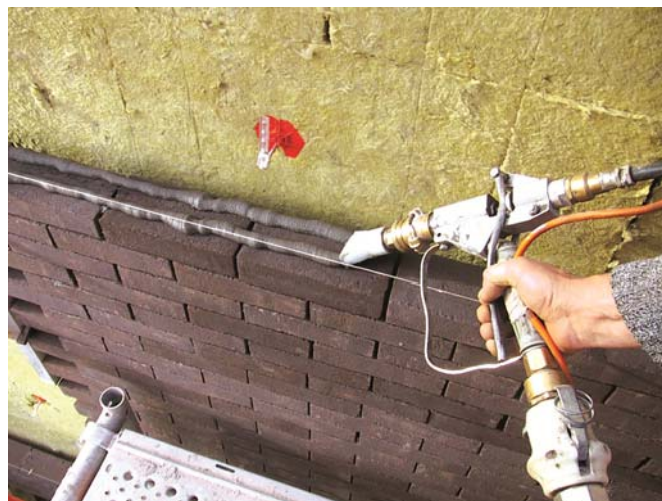
Pose à la machine à coller
