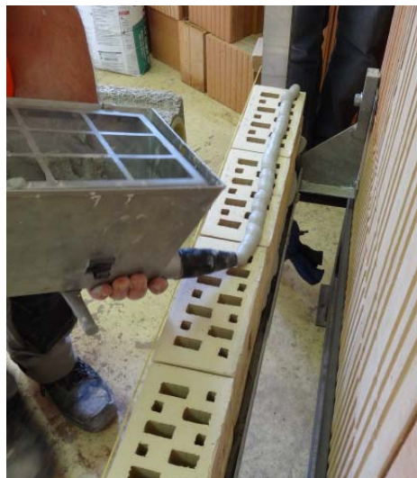
Pose à la pompe à mortier
