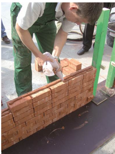
Pose à la poche à mortier
