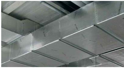
Figure 1 – Réseau de distribution par "conduits isolés"
