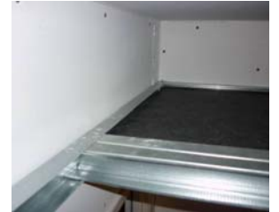
Figure 2 – Réseau de distribution par "plenums"
