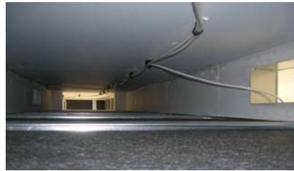
Figure 2 – Réseau de distribution par "plenums"
