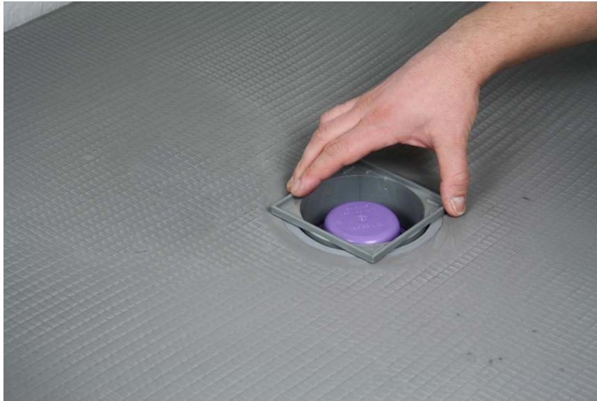
Figure 7 – Vérification de la bonne mise en place
