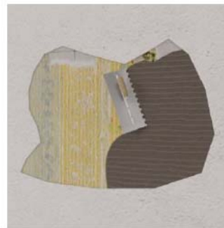
2 – Rebouchage des défauts localisés
