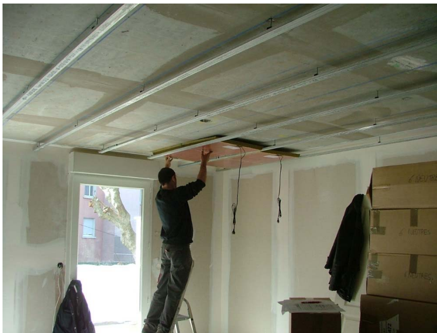
Figure 8 –Plafond rayonnant plâtre équipé de panneaux chauffants "SERTIKIT-PRP" ou " FRICOKIT®" en cours de réalisation
