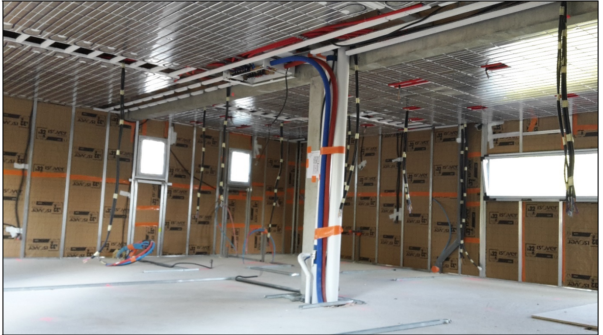
Figure B – Exemple de chantier en cours de réalisation
