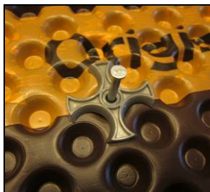
Fixation de la nappe DELTA®-MS
