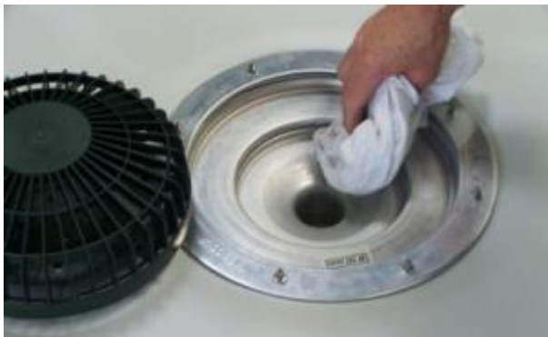
Figure 7.1 – Nettoyage de l'intérieur de la platine aluminium
