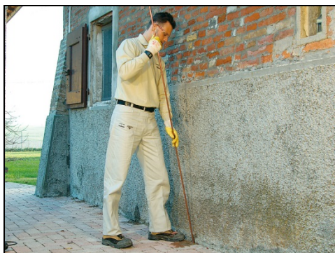
Photo 8. Phase mise en place des tuyaux
