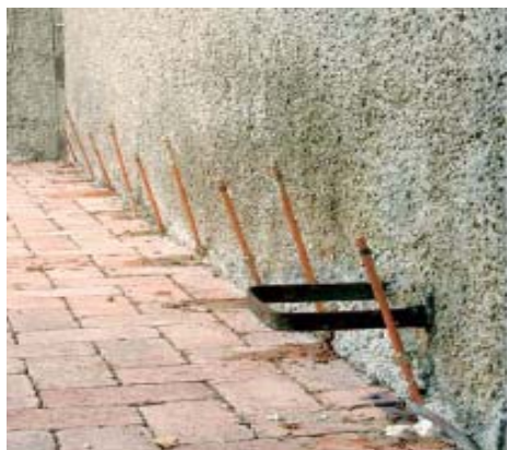
Photo 5. Position des tubes d'injection le long d'une semelle filante.
