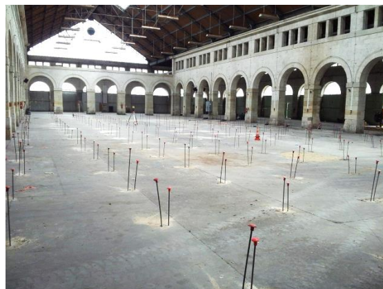
Photo 6. Maillage des tubes d'injection sur un dallage
