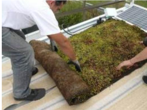
Figure 7 - Pose des tapis de sedum
