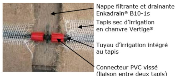
Figure 6 - Jonction de deux tapis successifs
