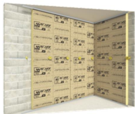
2. Mise en œuvre de l'isolant, verrouillage des platines et contrôle de la planéité
