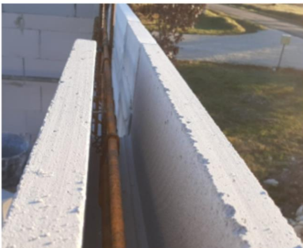
Chaînage horizontal avec blocs Ytong Compact 15 TU et aciers en attente de coulage
