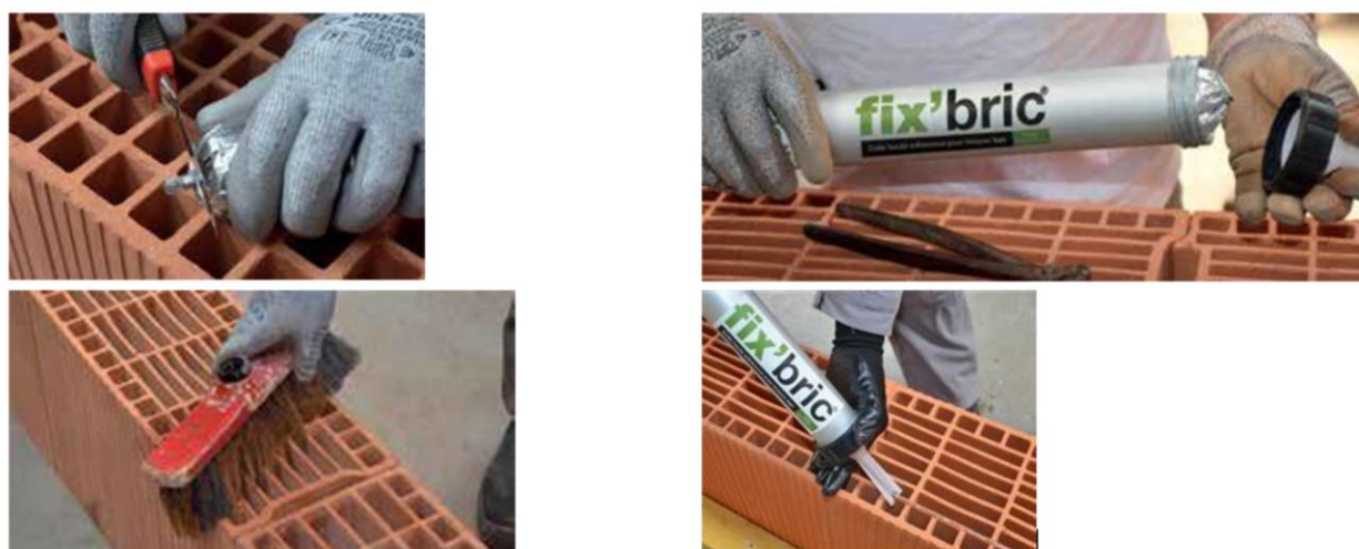
Figure 14 : Préparation pour la pose du procédé fix'bric
