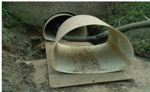
Figure 1 : Principe de réhabilitation par coque entière mono-élément.
