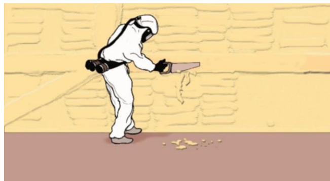
Figure 16 : Écrêtage des surépaisseurs
