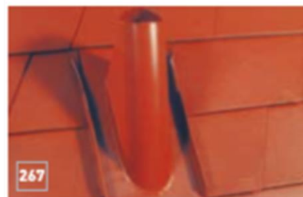
Figure 17 – Mise en œuvre des souches de ventilation préfabriquées
