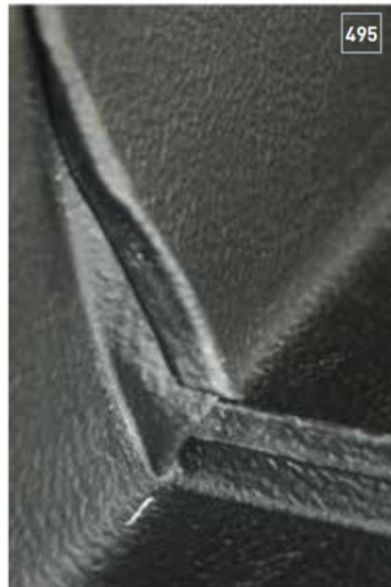
Figure 15 (suite) – Réalisation d'une grisonne (pente 5% minimum)
