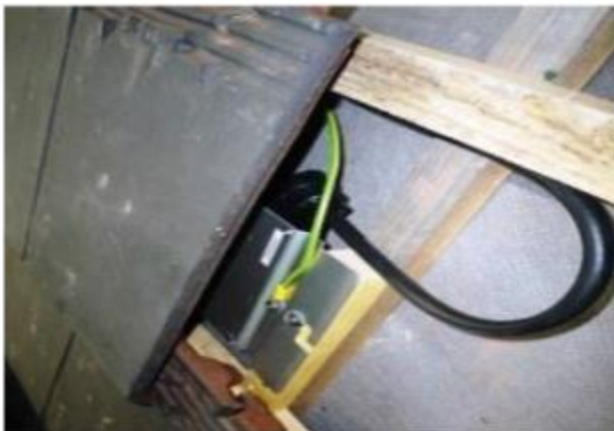
Figure 13 – Mise en œuvre d'un micro-onduleur
