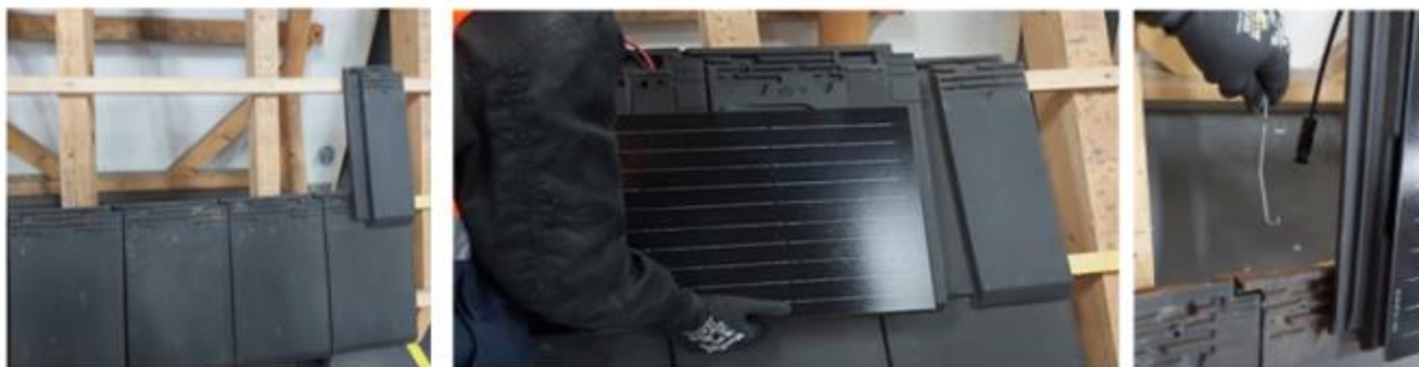
retirer les tuiles de couverture
