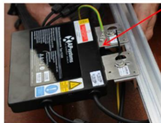
Figure 18 - Mise en place des micro-onduleurs
