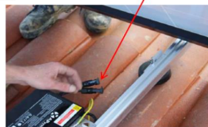
Figure 18 - Mise en place des micro-onduleurs
