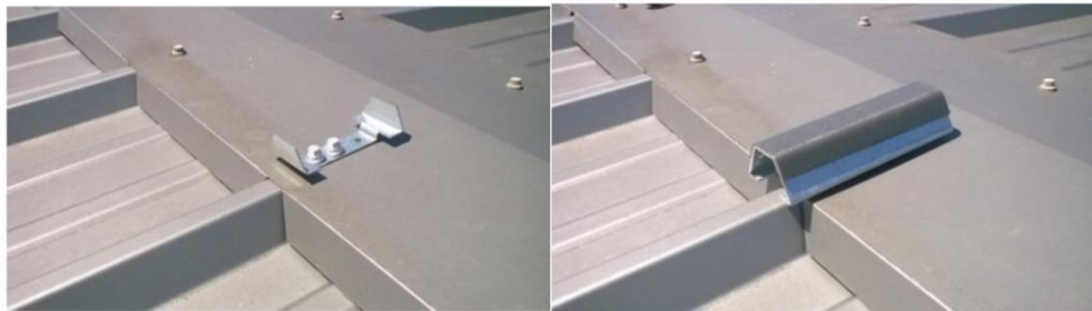
Figure 17 - Illustration de la fixation des panneaux sandwich à l'aide des rehausse inférieures avec la rehausse de blocage
