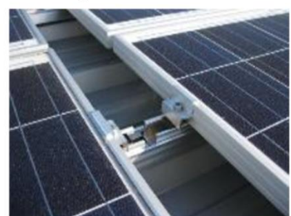
Au joint de dilatation
