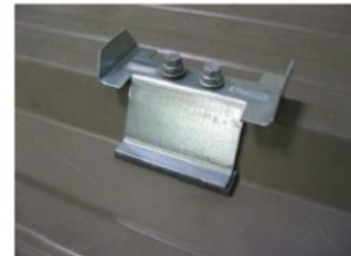
Figure 16 - Illustration de la fixation du perçage des panneaux sandwich et de la pose de l'entretoise (Cas simple vis ; pour le cas double vis cf. Figure 20)
