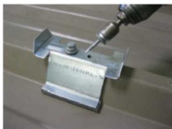
Figure 16 - Illustration de la fixation du perçage des panneaux sandwich et de la pose de l'entretoise (Cas simple vis ; pour le cas double vis cf. Figure 20)
