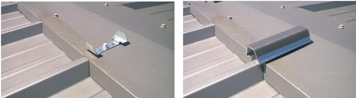
**Positionnement des rehausse de faîtière : une seule par colonne de rails**
