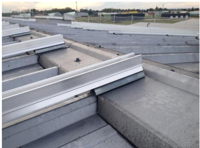
**Figure 20 – Illustration de l'utilisation de la rehausse supérieure sur la rehausse inférieure**
