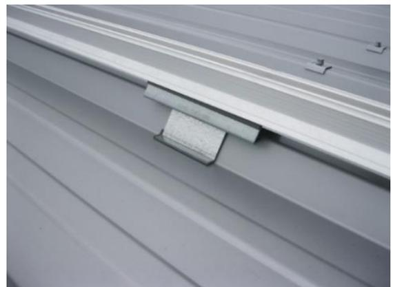
Figure 22 – Calepinage des rails
