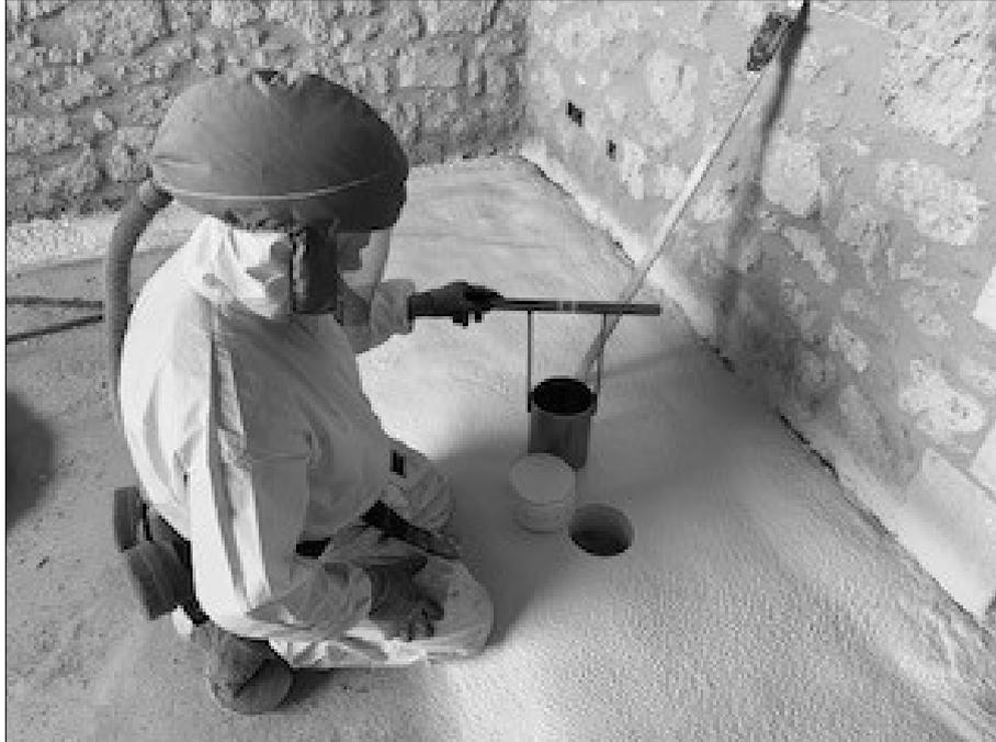
Figure 1 : Prélèvement des éprouvettes par carottage
