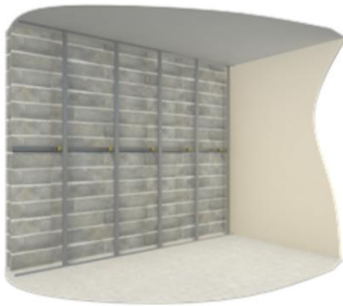
Figure 3-1 : Pose de l'ossature métallique Optima (Lisses, Fourrures, Rallonges et appuis Optima 2 )
