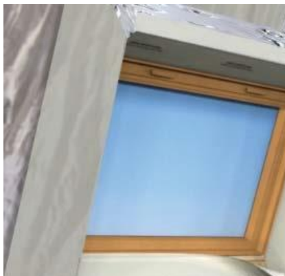
Figure 16 : Raccord à la partie courante
