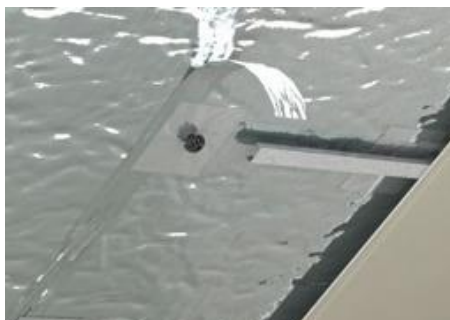
Figure 13 : Mise en œuvre du parement de finition
