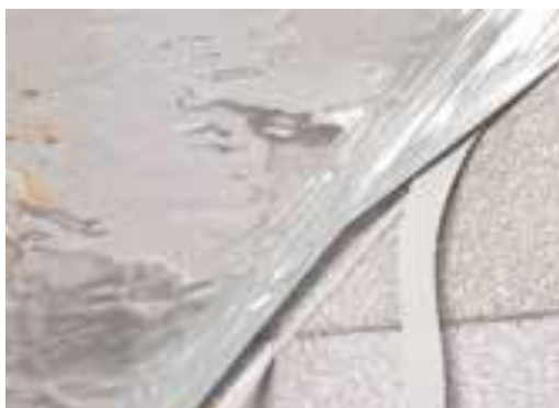
Figure 12 : Mise en œuvre du Mastic RT
