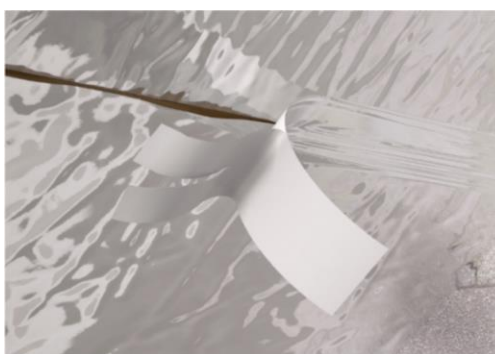
Figure 11 : Réalisation de la jonction des lés d'isolant RT Plus avec l'adhésif RT Plus
