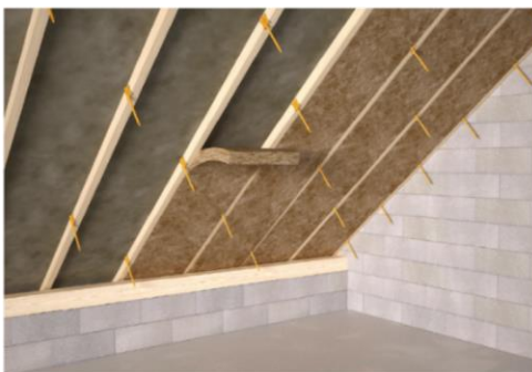
Figure 6 : Pose de la 1 ère couche d'isolant entre chevrons / fermettes
