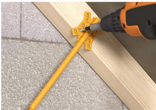
Figure 5 : Vissage des Suspentes RT sur la charpente
