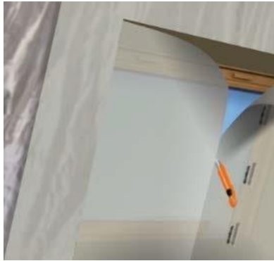
Figure 14 : Mise en œuvre du pare vapeur indépendant
