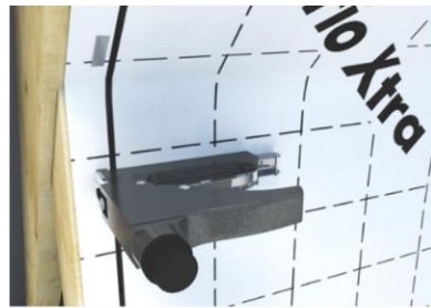
Agrafer la membrane sous les fermettes
