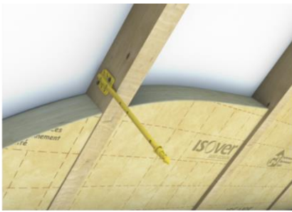
Visser la tige sur le flanc du chevron
