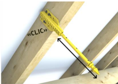
Visser la platine sur le flanc du chevron, régler la longueur de la tige et la verrouiller en ¼ de tour
