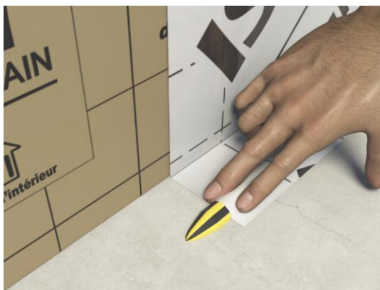
Figure 8 : Précautions à prendre lors de la pose du mastic VARIO® DOUBLE FIT ou DOUBLE FIT+
