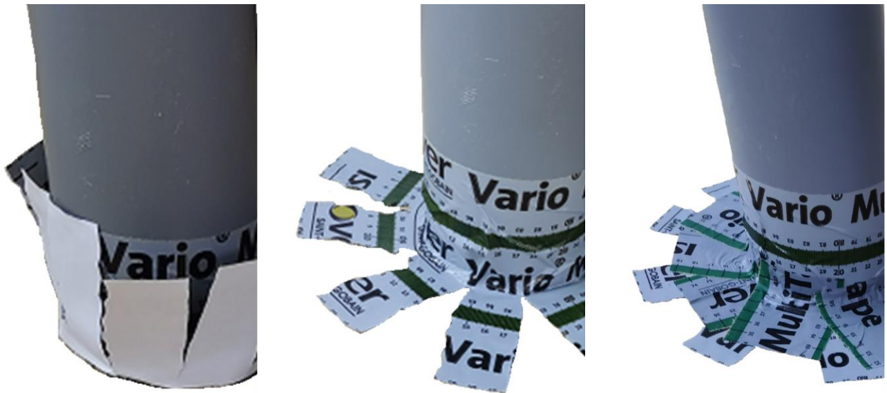
Figure 40 : pose du Multitape autour du conduit pour assurer l'étanchéité à la vapeur d'eau entre la membrane et le conduit
