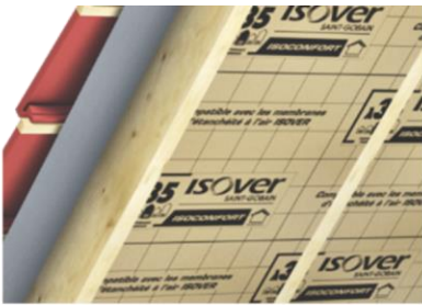
Placer l'isolant entre fermettes
