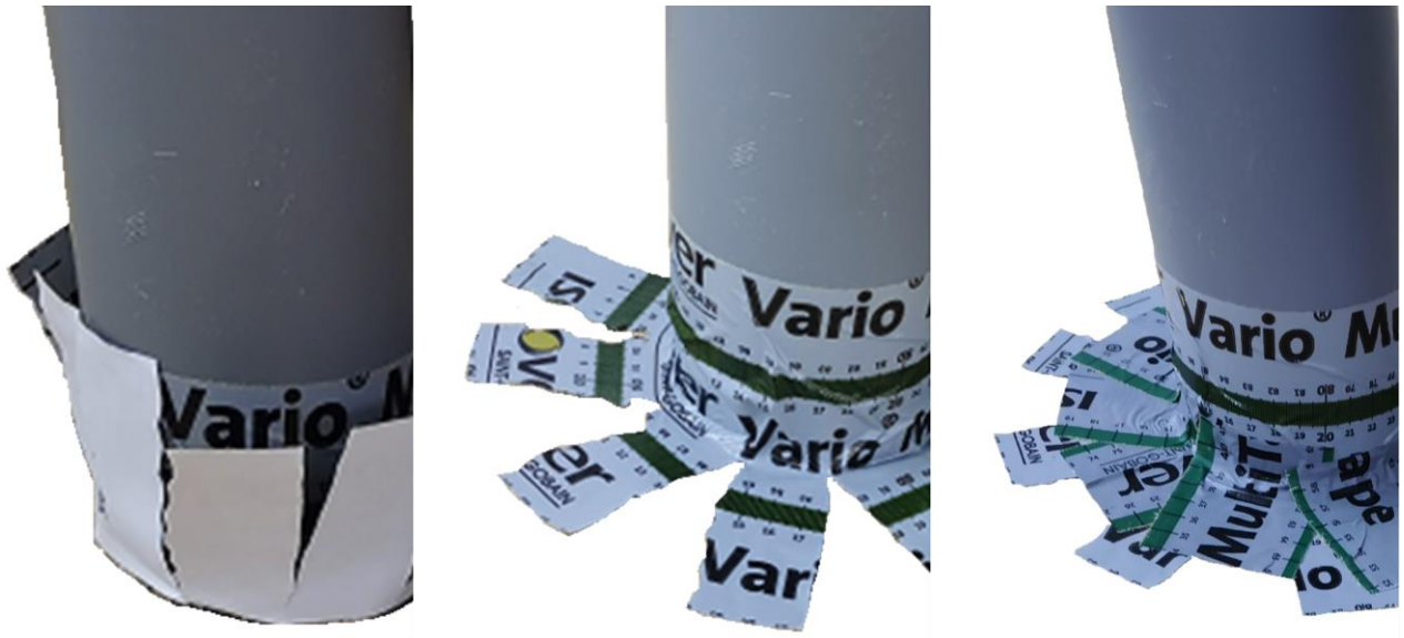
Figure 31 – Etanchéité de la jonction du conduit avec la membrane avec l'adhésif VARIO® MULTITAPE.
