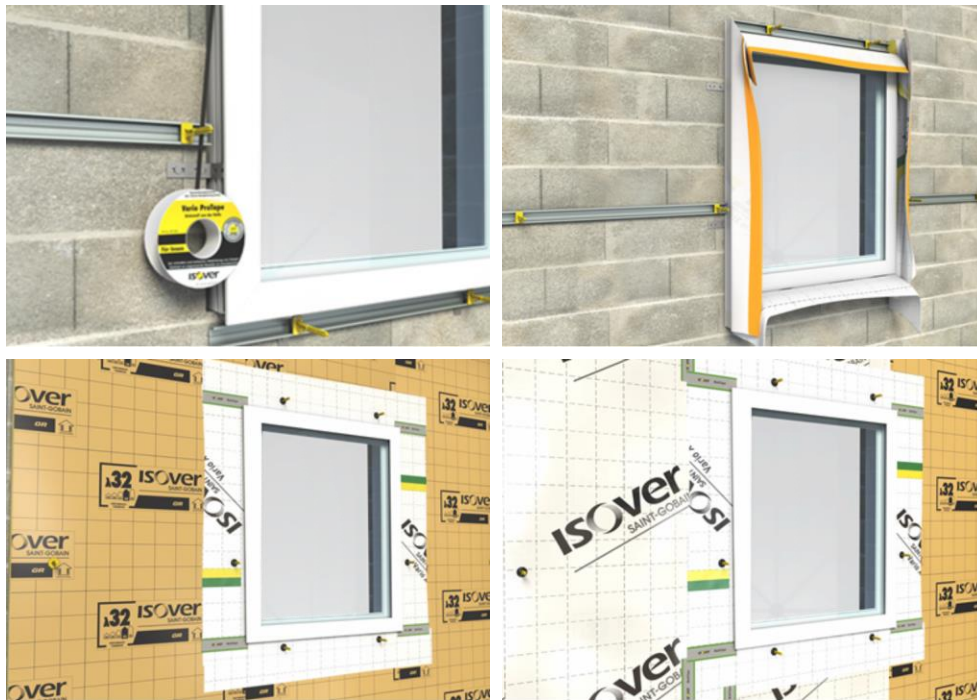
Figure 21 - Entourage des fenêtres posées en applique intérieure avec le VARIO® XTRA BAND. Pose du Joint Ruban Vario®Protape autour de la menuiserie et pose de la Vario®Xtra Band, puis collage de la Vario®Xtra Band sur la membrane et pose de l'adhésif Vario® Multitape aux angles pour parfaire l'étanchéité à l'air.
