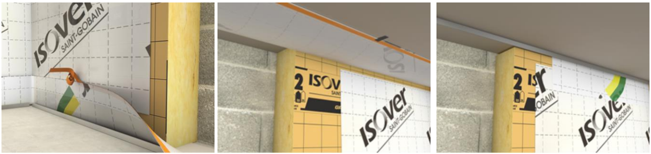
Figure 9 – Finalisation de la jonction avec les parois périphériques munies de VARIO® XTRA BAND.
