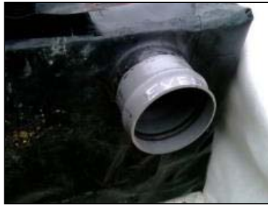
Figure 3b – Système RAINBOX® CUBE CHANNEL équipé d'un évent DN/OD 200
