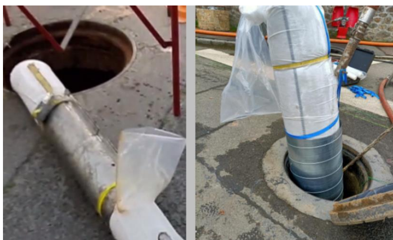
Figure 3 : Modèles de contre-moule pouvant être utilisés pour récupérer un échantillon en extrémité, au diamètre de la canalisation
