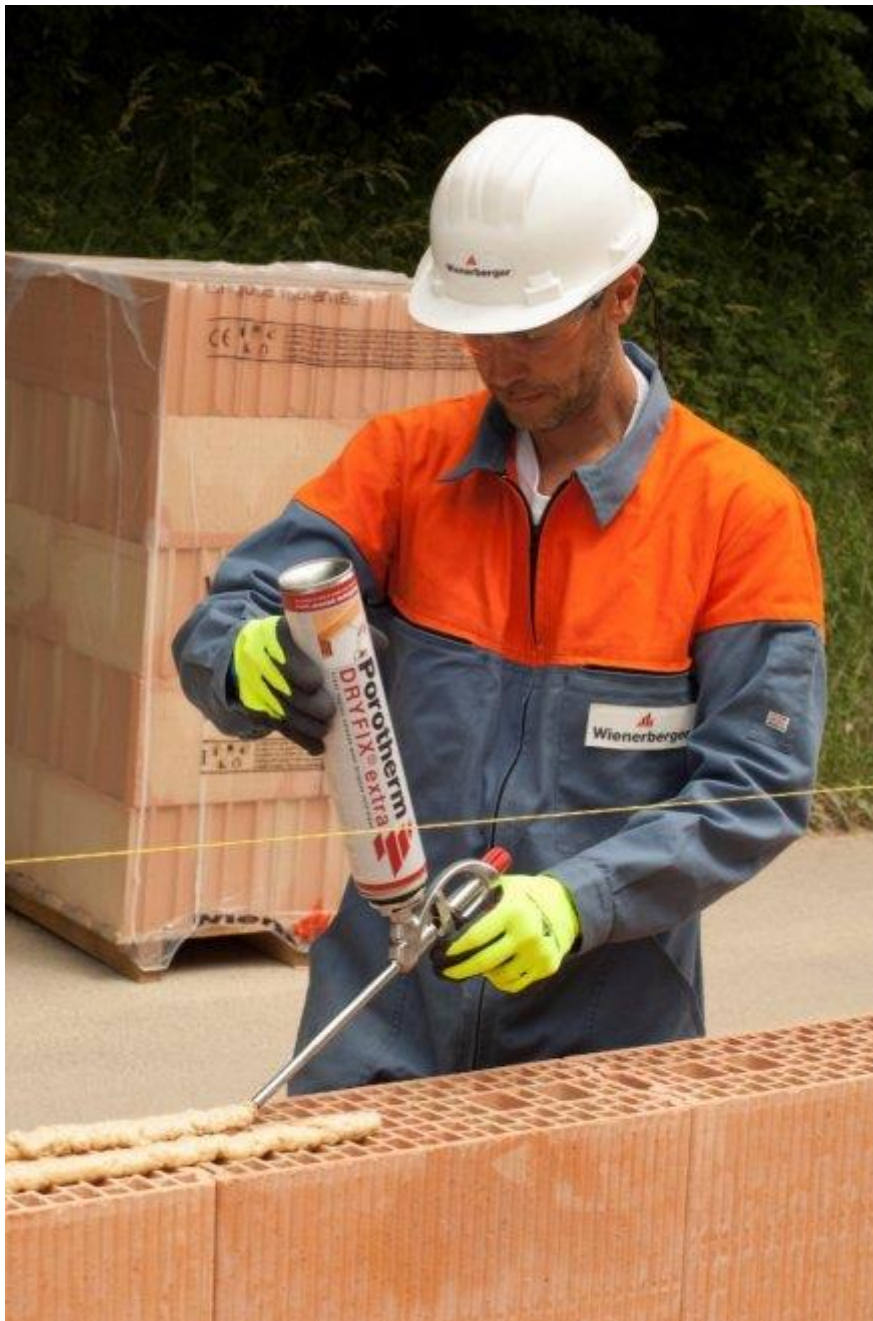
Figure 13 – Assemblage au DRYFIX
