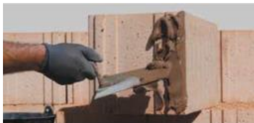
Figure 18 – Illustration du remplissage des joints verticaux
