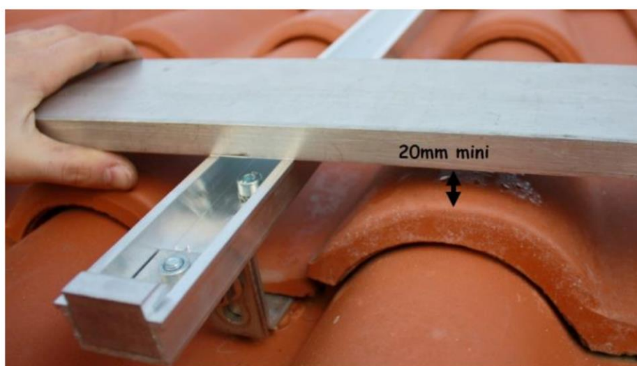
Réglage de la hauteur des pattes de fixation
