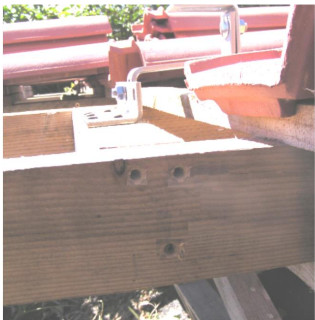
Fixation des ancrés sur chevêtre
