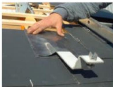
Figure 15 – Exemple de montage du kit de fixation pour 1 capteur horizontal sur toiture ardoise
