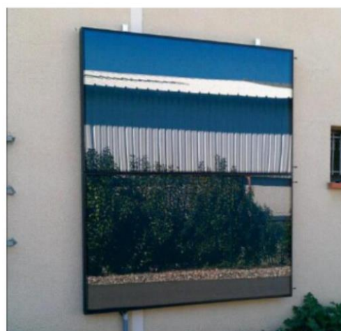
Figure 23 – Exemple de montage mural pour 2 capteurs horizontaux
