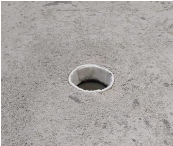
Photo 1d – Mise en œuvre de la chape et arasage de la sous couche
