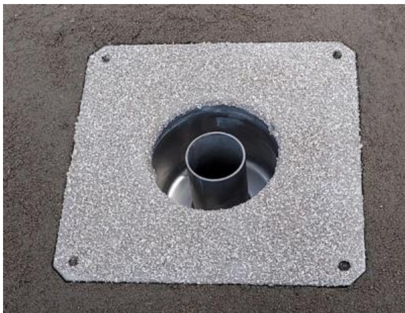
Photo 1h – Primairisation et sablage de la platine du siphon acoustique
