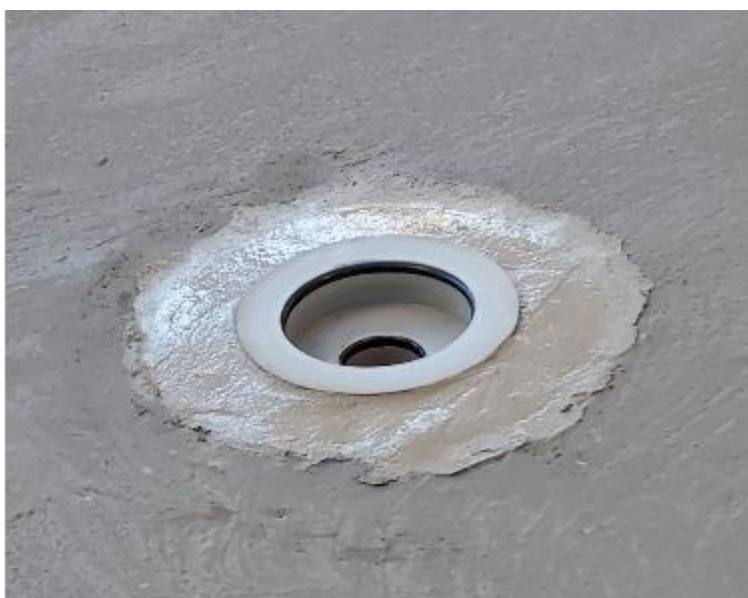
Photo 1b - Mise en œuvre de l'embase du siphon acoustique
