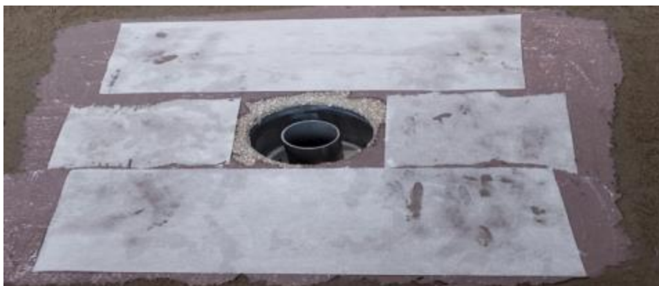
Photo 1i – Traitement du raccord platine et chape, mise en place des bandes
