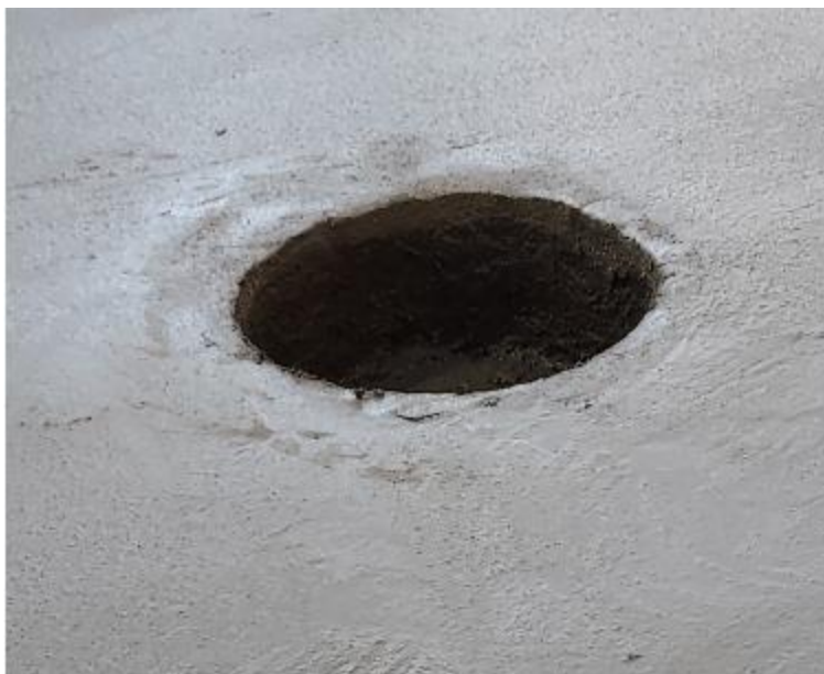
Photo 1a – Réalisation du carottage
