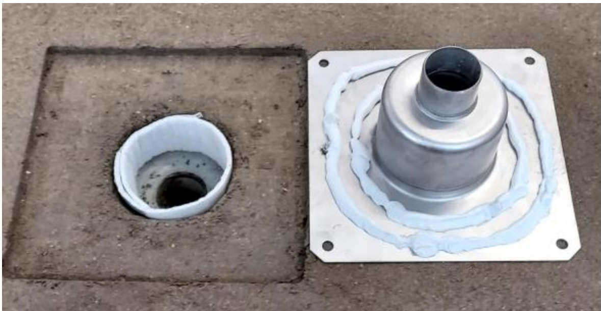
Photo 1f – Collage du corps du siphon
