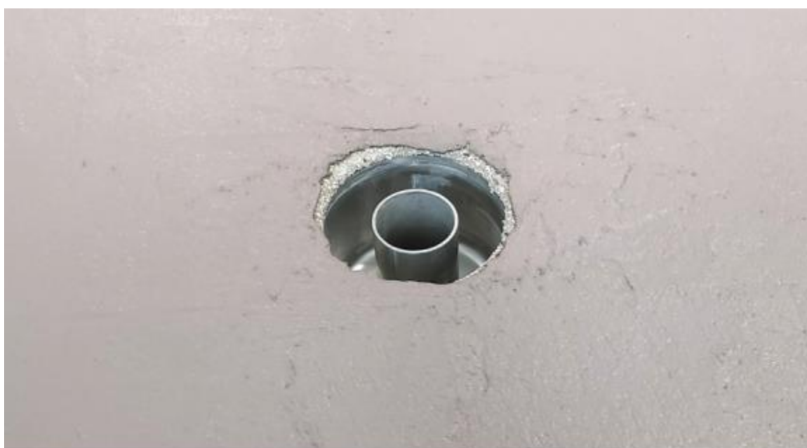
Photo 1k - Etanchéité en partie courante
