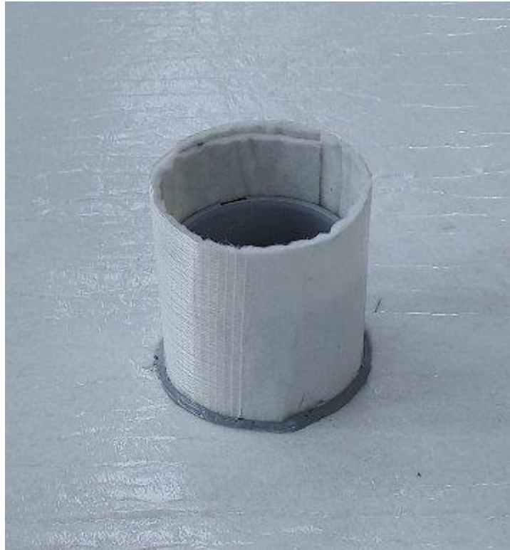
Photo 1c – Réalisation de l'étanchéité entre la SCAM et le manchon
