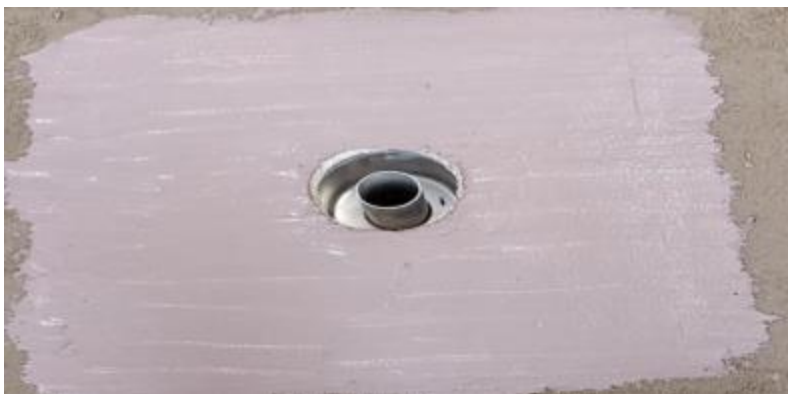
Photo 1j – Traitement du raccord platine et chape, marouflage de la bande
