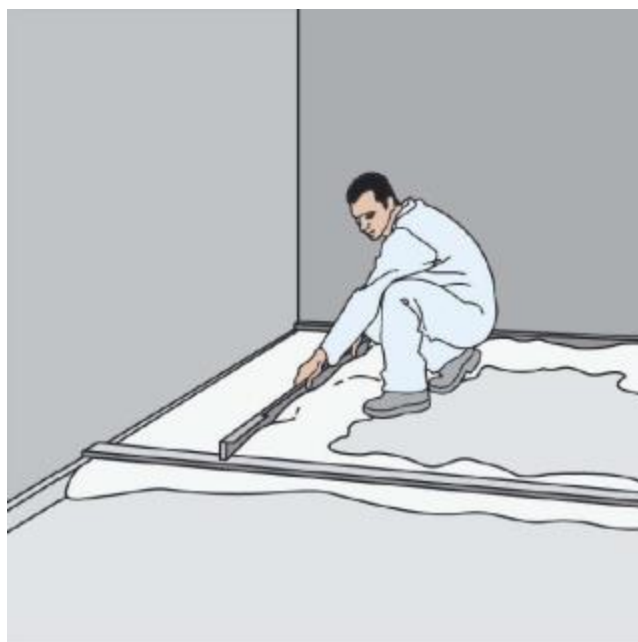
Figure 4 - mise en œuvre des granulats d'égalisation
