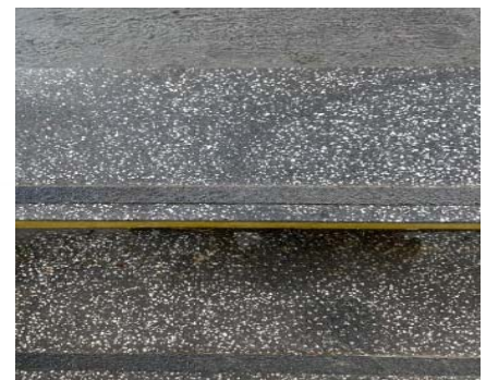
Détail photo Escalier NEOPHALTE DECOR avec protection réglementaire de type bande antidérapante
