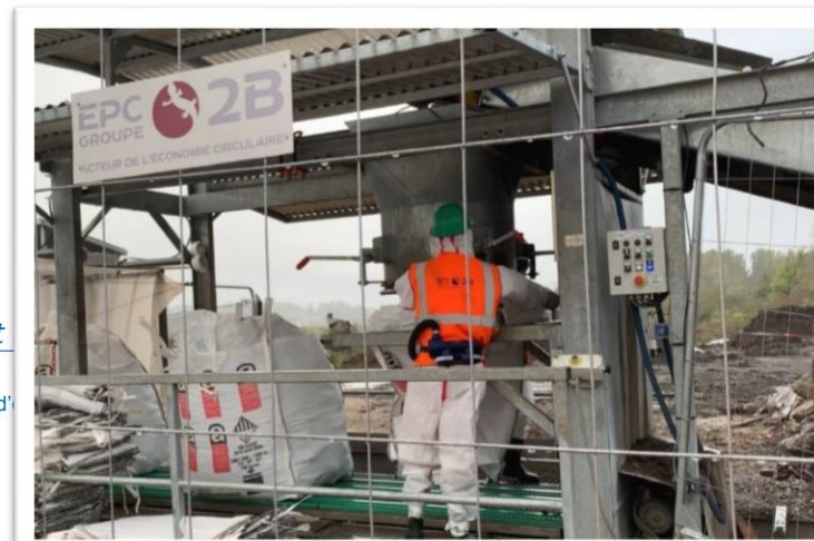
Photos 3 et 4 : Mise en place du big-bag sous la trémie
