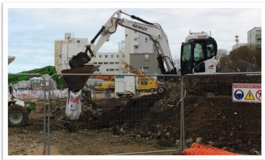
Remplissage du big-bag par une pelle équipée d'un godet. Engins de chantiers dans la zone de travail.
