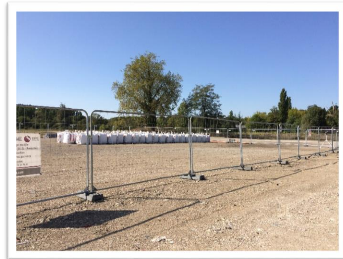
Big-bags en zone de stockage provisoire de déchets
