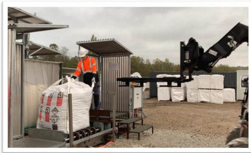
Récupération du big-bag lavé par un chariot télescopique situé en dehors de la zone de travail
