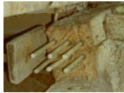
Restauration d'une vieille poutre de charpente
