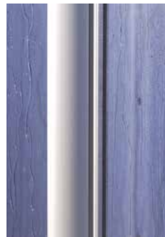
Essai d'étanchéité à l'eau
