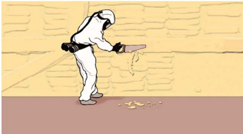
Figure 17 : Ecrêtage des surépaisseurs
