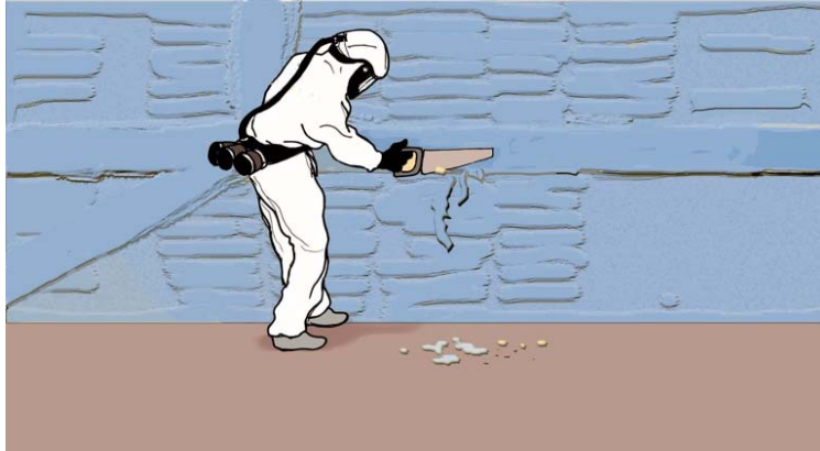
Figure 12 : Écrêtage des surépaisseurs
