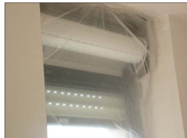
Figure 2 : Protection d'une menuiserie
