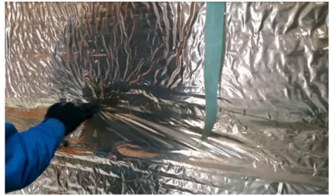
Figure 35 : adhésif marouflé sur l'isolant
