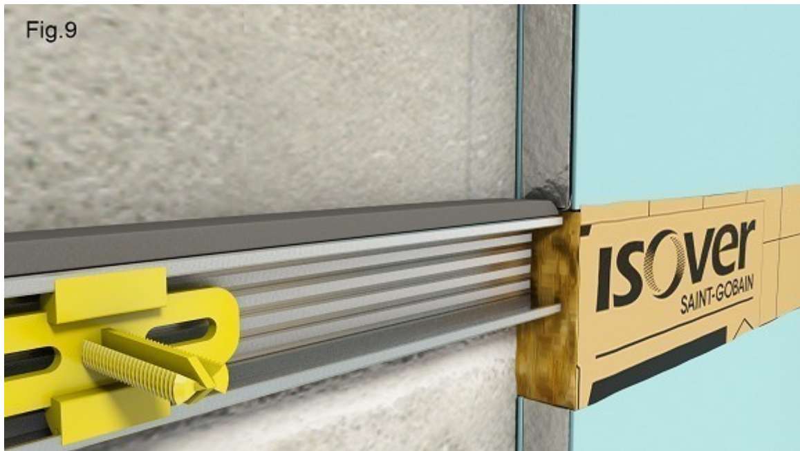
Figure 9 - Pose de la laine de verre GR 32 sur la lisse intermédiaire
