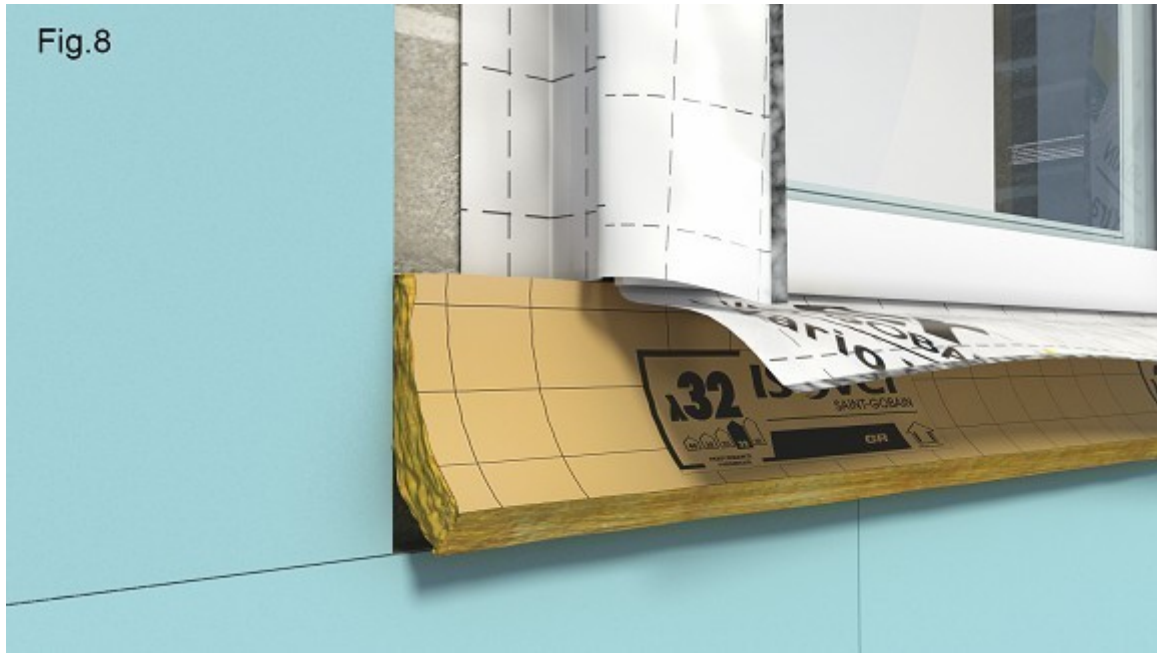
Figure 8 - Pose de la laine de verre GR 32 après pose des ISOVIP périphérie de menuiserie
